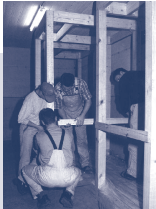
----- Bau der Erinnerungsstätte zur Geschichte der Zwangsarbeit im Volkswagenwerk 1999. Kooperationspartner bei der Realisierung des Vorhabens waren das Unternehmensarchiv, die Volkswagen Coaching Gesellschaft mbH sowie der Gesamtbetriebsrat und die Jugendvertretung. VW-Auszubildende beteiligten sich mit Projektarbeiten am Bau der Erinnerungsstätte.
