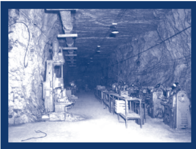
Blick in einen der Fabrikationsstollen nach Abzug der KZ-Häftlinge, September 1944
