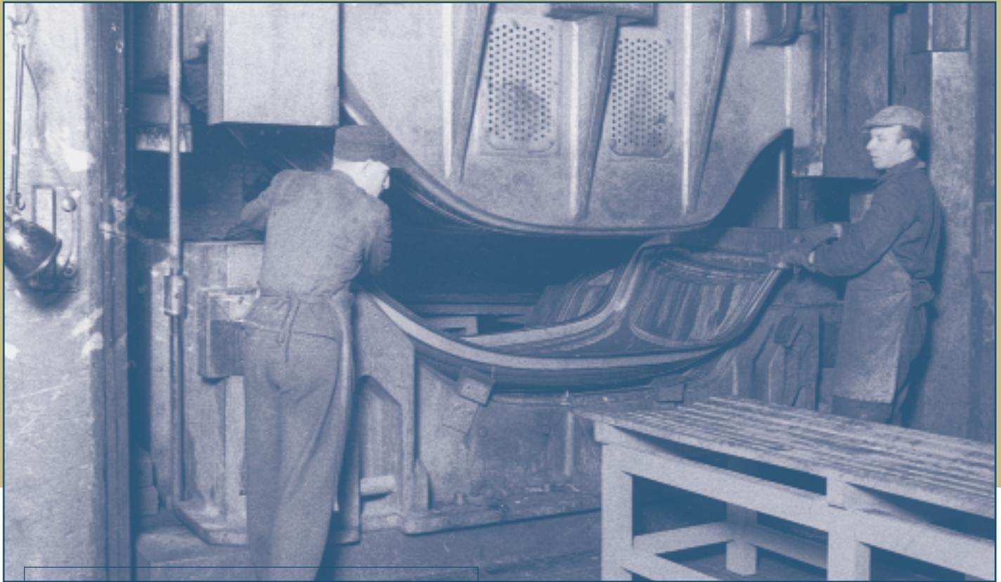
Arbeiter entnehmen der Presse das Dach einer Limousine.
