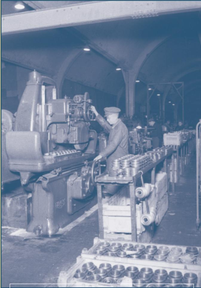
Wegen ausbleibender Zulieferungen musste das Volkswagenwerk zusätzliche Fahrzeugteile selbst fertigen.
