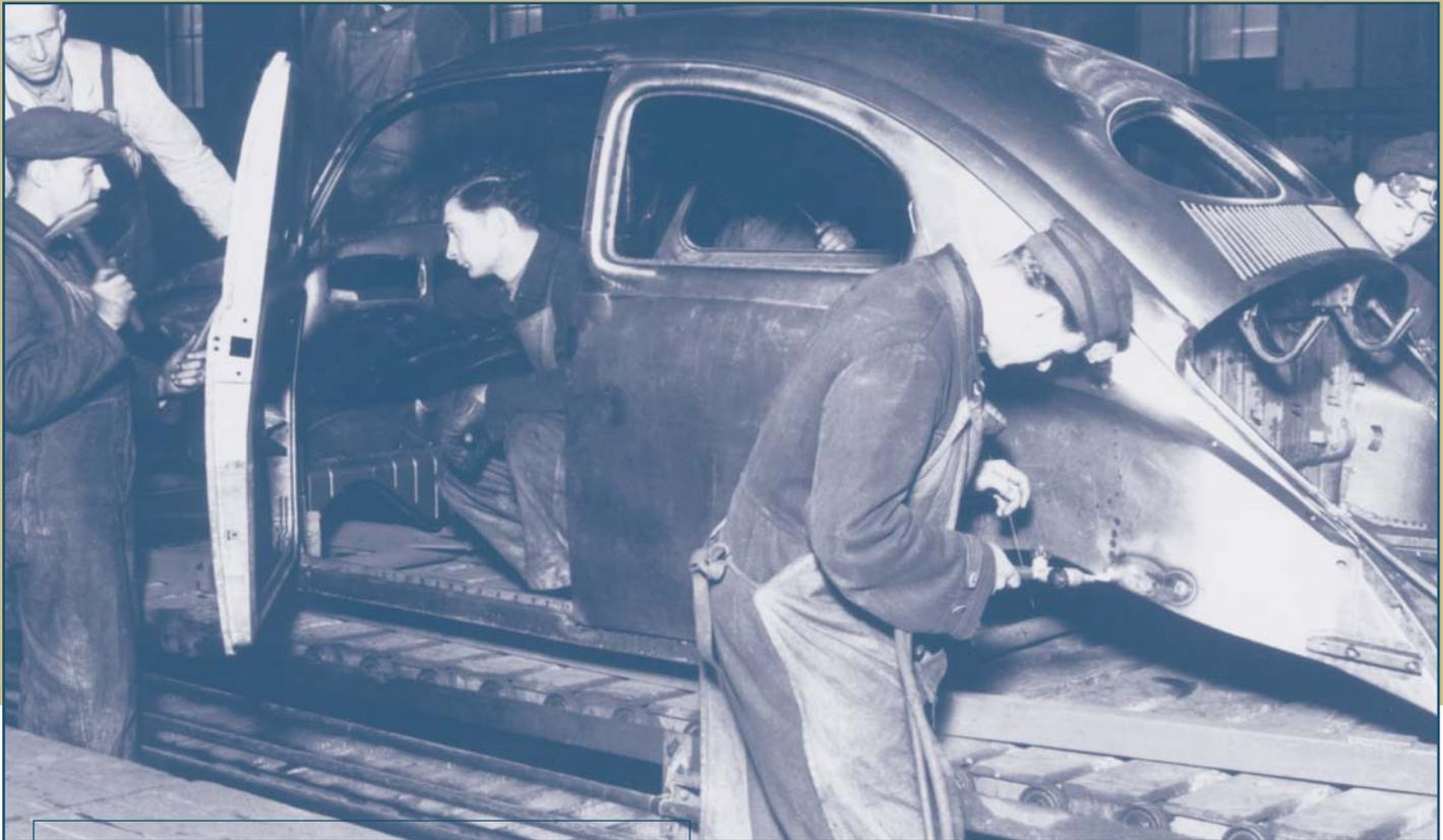
**Fehlende Werkzeuge, Maschinenreparaturen und Arbeitskräfteengpässe beeinträchtigten die Montage des Volkswagens.**
